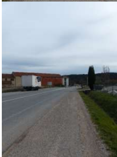
Abords routiers de la déviation non aménagés
