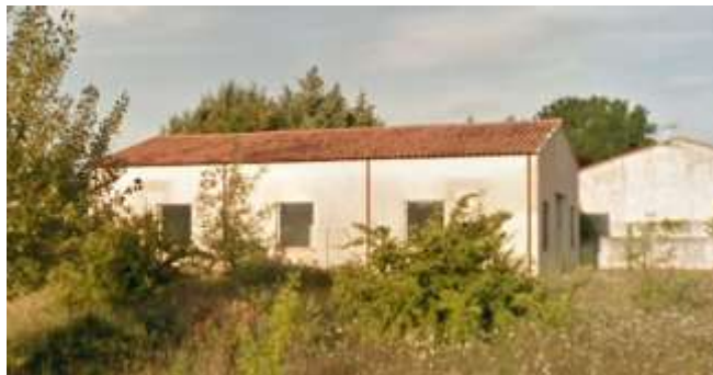
Bâtiment de type hangar
